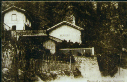
La fermata di Bergeggi e il casello
