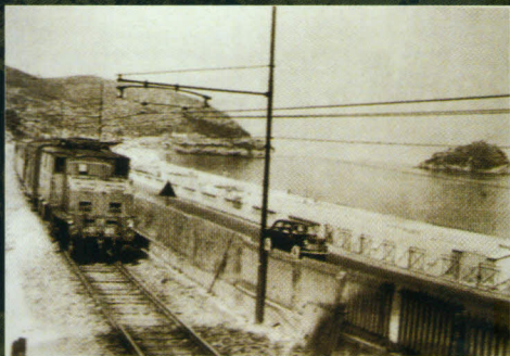
Locomotiva Elettrica Trifase E 431
